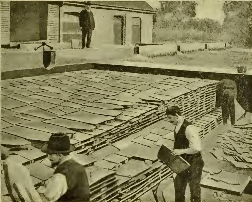
Fig. 8. — Construction d'un lit d'ardoises à Malden (Surrey).
